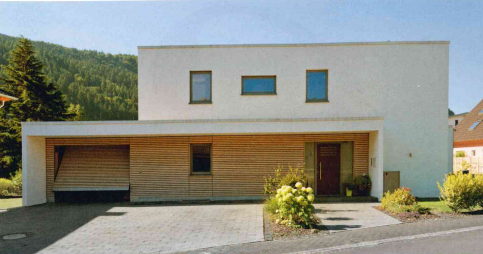
Eingang und Garage bilden durchgehend holzverschalt eine Einheit und ermöglichen überdacht den Weg vom Auto zur Tür trockenen Fußes.
