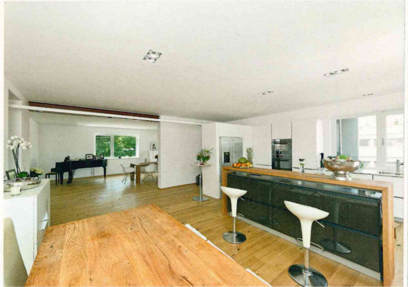
Vom Flügel bis zur Küche reicht der Blick. Für das weite Raumgefühl mussten Wände weichen, die zum Teil durch Stahlträger ersetzt wurden.
