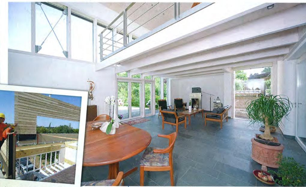
„Schlanke, bis unters Dach laufende Balken bilden das tragende Skelett des Gebäudes, was zusammen mit den großen Glasflächen eine sehr filigrane Architektur ermöglicht.“ *Der Architekt*
